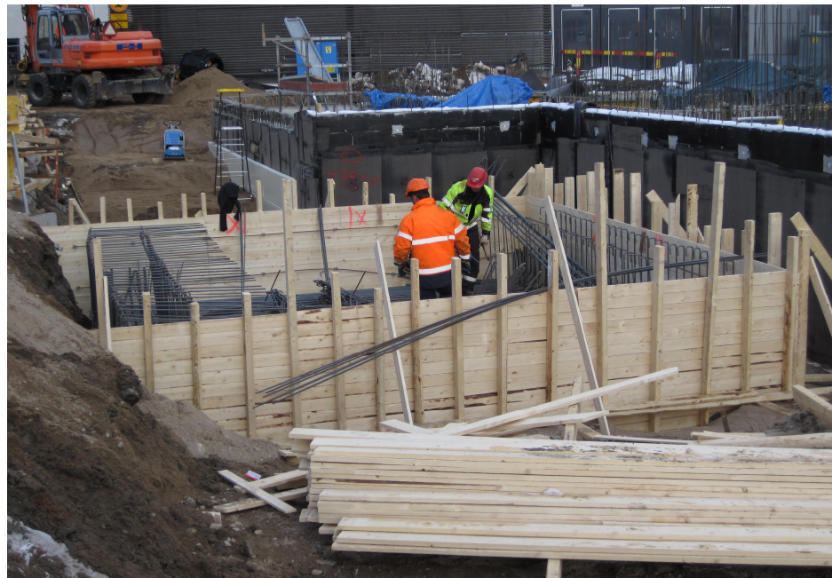
Torninosturin perustuksen muotitus käynnissä.
